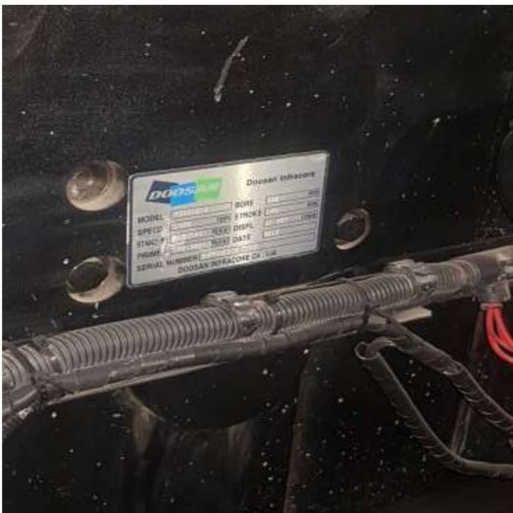
Imagen 10. Placa de información técnica – Planta de emergencia CC Jardín Plaza.
